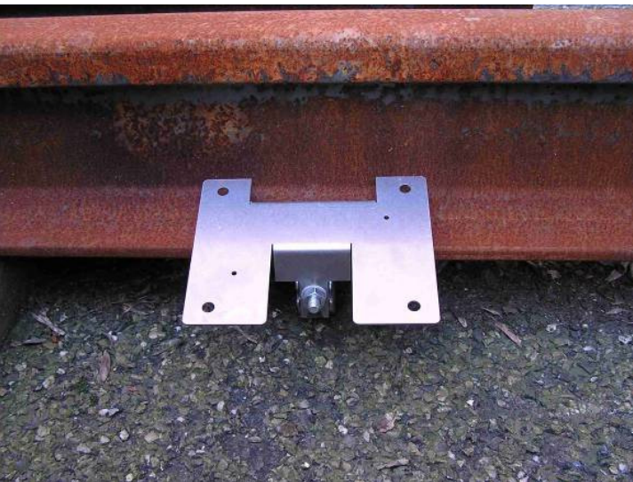
Montierte Montageplatte für Flugschneefühler
